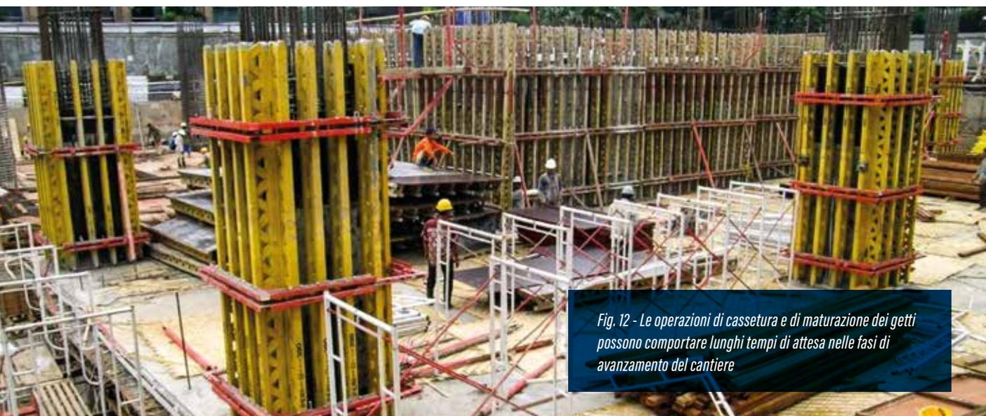
*Fig. 12 - Le operazioni di cassetta e di maturazione dei getti possono comportare lunghi tempi di attesa nelle fasi di avanzamento del cantiere*
