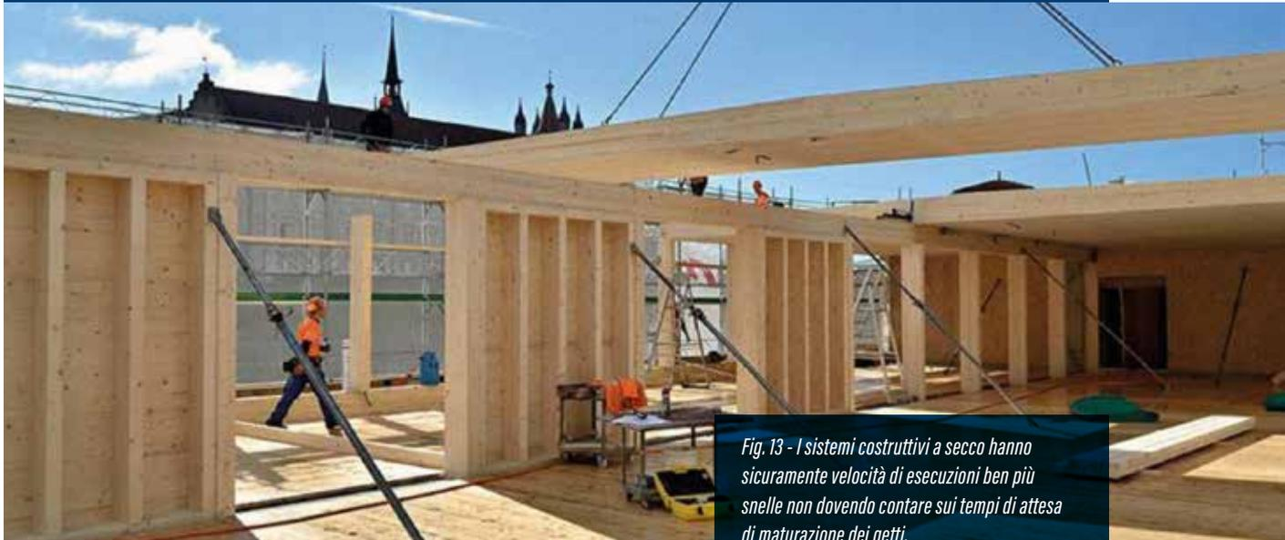
*Fig. 13 - I sistemi costruttivi a secco hanno sicuramente velocità di esecuzioni ben più snelle non dovendo contare sui tempi di attesa di maturazione dei getti.*
