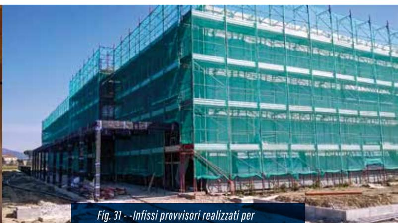
*Fig. 31 - Infissi provvisori realizzati per proteggere le strutture durante il cantiere.*
