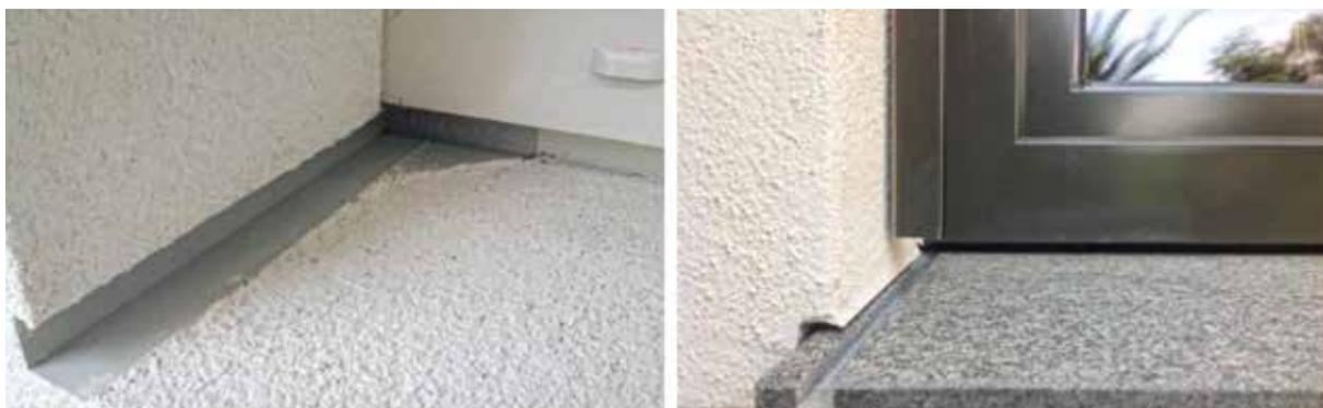
Fig. 25 - a sinistra: profilo per l'intonaco preparato per montaggio del davanzale con una seconda superficie drenate. A destra: il davanzale in pietra viene infilato e opportunamente fissato; da notare la fessatura sul bancale per favorire il deflusso delle acque verso l'esterno.
