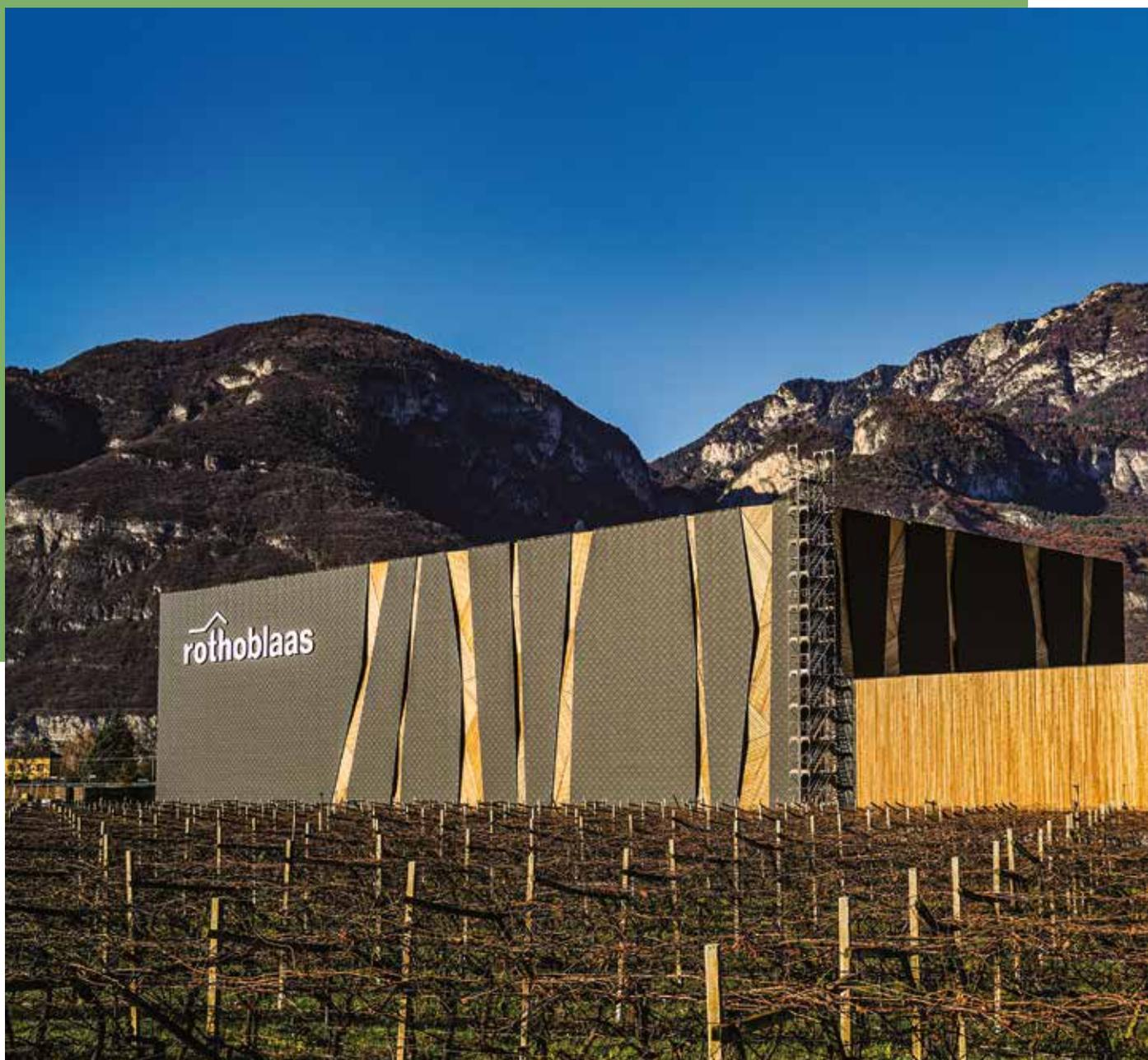
Il magazzino automatizzato autoportante in legno, adiacente al quartier generale di Rothoblaas, è situato nel comune di Cortaccia sulla Strada del Vino (BZ). Si tratta del primo magazzino automatico autoportante completamente in legno edificato in Italia e uno dei pochissimi esemplari costruiti finora al mondo. Rothoblaas punta ad un futuro ecosostenibile ed è stato naturale scegliere di realizzare la struttura e le componenti del magazzino automatico in legno.
