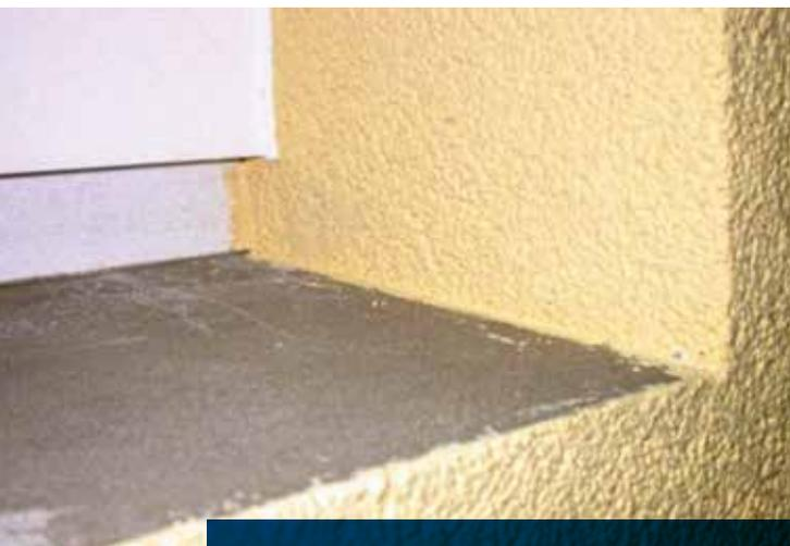
Fig. 24 - Superficie impermeabile del parapetto trattato finito
