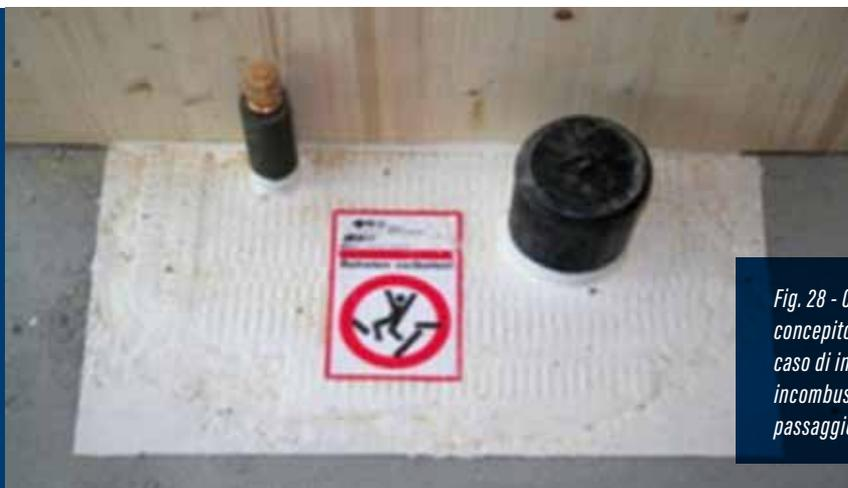
*Fig. 28 - Cavedio correttamente concepito per la sicurezza in caso di incendio (materiale incombustibile a protezione del passaggio impiantistico)*
