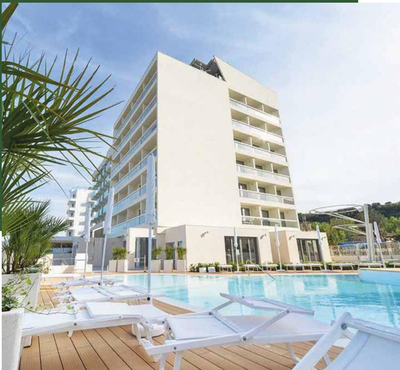
Realizzato nel 2016 a Pesaro da Centroleghno con pannelli forniti da MAK Building, l'Hotel Nautilus è una struttura ricettiva di sette piani fuori terra costruita interamente con pannelli CLT. L'edificio, progettato nel rispetto dei più rigorosi criteri di resistenza sismica ed eretto utilizzando complessivamente 788 metri cubi di legno, è alto 27 metri e ha una superficie lorda totale di 2.458 metri quadri.
