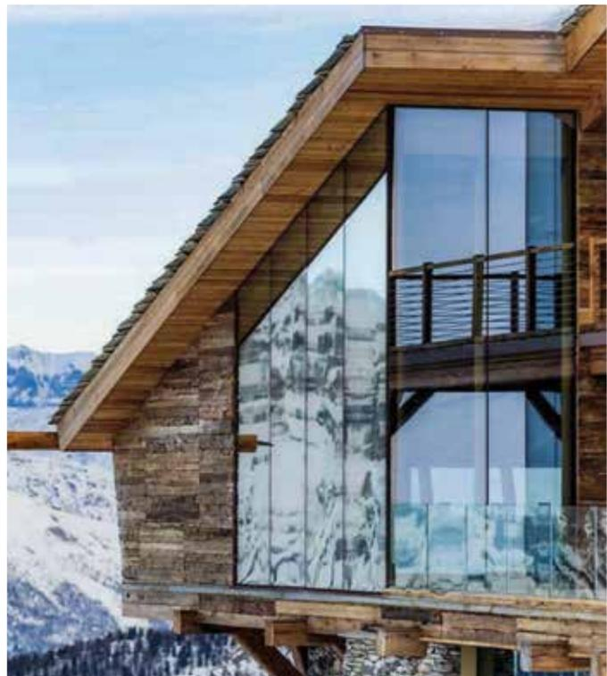
I dettagli progettuali sono stati concepiti con la filosofia Passivhaus, mediante ottimo isolamento termico dell'involucro, tenuta all'aria degli elementi costruttivi, ventilazione controllata con recupero di calore e vetrate con tripli vetri basso emissivi. La scelta dei materiali incorpora sia la tradizione, con il riuso della pietra dell'edificio in demolizione, che la modernità delle superfici vetrate di ultima generazione ad elevate prestazioni tecniche.
