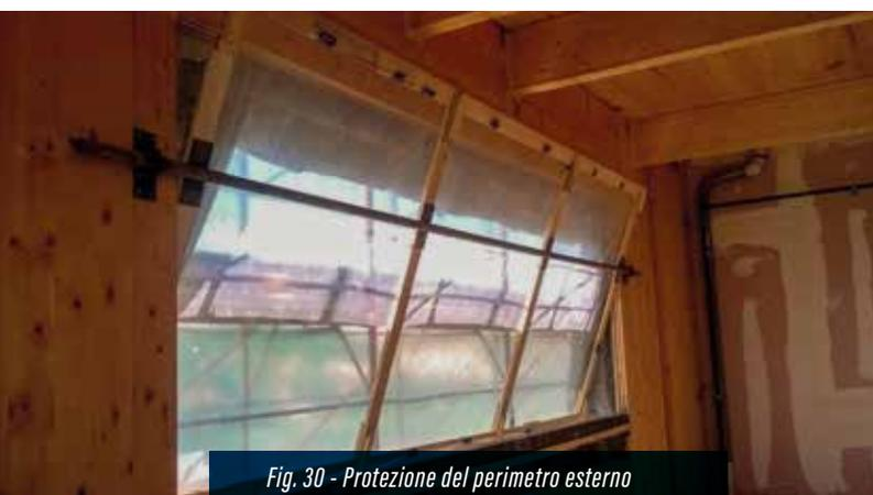
*Fig. 30 - Protezione del perimetro esterno dell'edificio con teli impermeabili traspiranti.*
