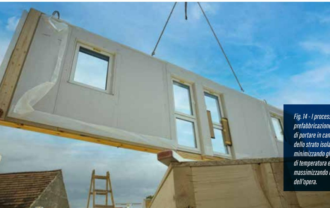
*Fig. 14 - I processi di industrializzazione e prefabbricazione in stabilimento permettono di portare in cantiere elementi già provvisti dello strato isolante e dei serramenti, minimizzando gli errori, eliminando le variabili di temperatura e umidità, e contestualmente massimizzando la qualità costruttiva dell'opera.*
