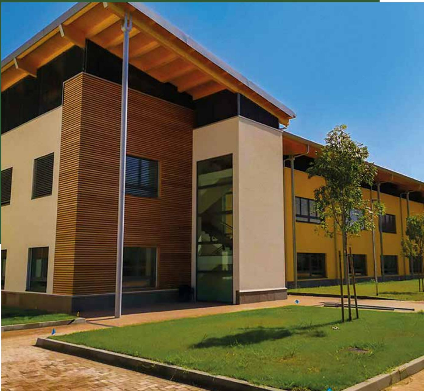
La nuova scuola media E. Chini di Mezzocorona (TN) è stata realizzata completamente in legno da STP utilizzando pannelli CLT forniti da MAK Building e realizzati da Stora Enso e materiali sostenibili. I lavori, durati due anni, hanno portato alla nascita di una struttura completamente nuova composta da 25 ambienti tra aule e laboratori, una biblioteca, un archivio e un auditorium. A questi si aggiungono la palestra e la mensa, esterni al corpo della scuola.
