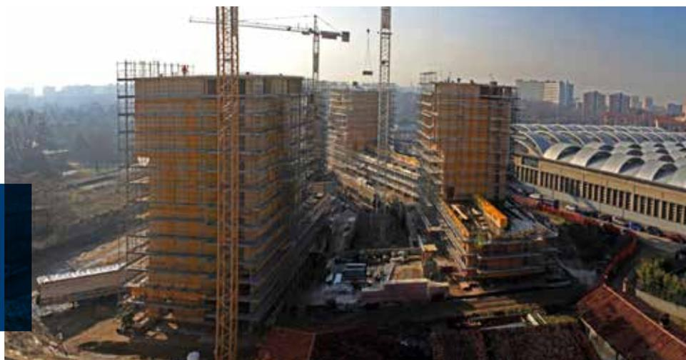
*Fig. 18 - Edificio di Via Cenni a Milano: quattro torri di 9 piani interamente in legno (Courtesy: Polaris sgr)*
