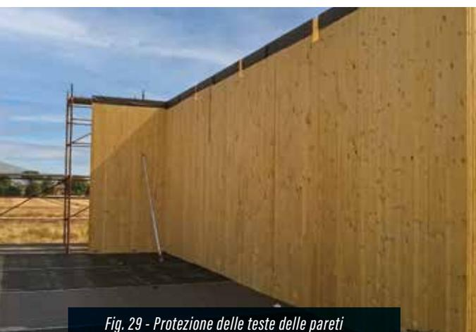
*Fig. 29 - Protezione delle teste delle pareti con guaine traspiranti durante il cantiere*
