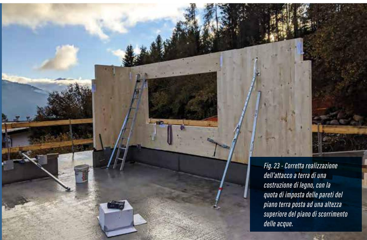
*Fig. 23 - Corretta realizzazione dell'attacco a terra di una costruzione di legno, con la quota di imposta delle pareti del piano terra posta ad una altezza superiore del piano di scorrimento delle acque.*
