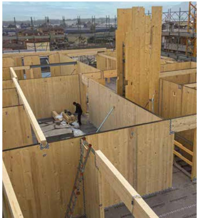
meccaniche del materiale e hanno portato alla progettazione di sistemi di carpenteria metallica ad hoc per trasferire i carichi strutturali alle fondazioni.
